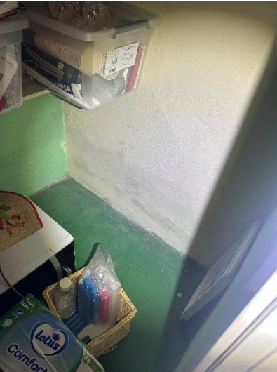
Missfärgningar/microbiellpåväxt, fuktgenomslag, färg och putssläpp förekommer sporadiskt i källaren.
