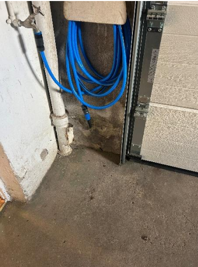
Missfärgningar/microbiellpåväxt, fuktgenomslag, färg och putssläpp förekommer sporadiskt i källaren.
