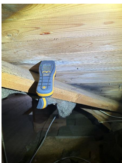
Vid stickprov i underlagstaket noterades 10,3%, 8,0% och 8,9%. Missfärgningar, microbiellpåväxt och fuktgenomslag.
