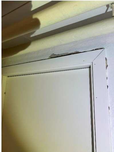
Missfärgningar/microbiellpåväxt, fuktgenomslag, färg och putssläpp förekommer sporadiskt i källaren.
