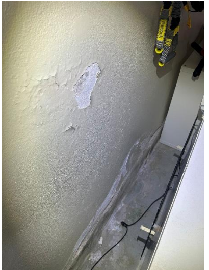
Missfärgningar/microbiellpåväxt, fuktgenomslag, färg och putssläpp förekommer sporadiskt i källaren.
