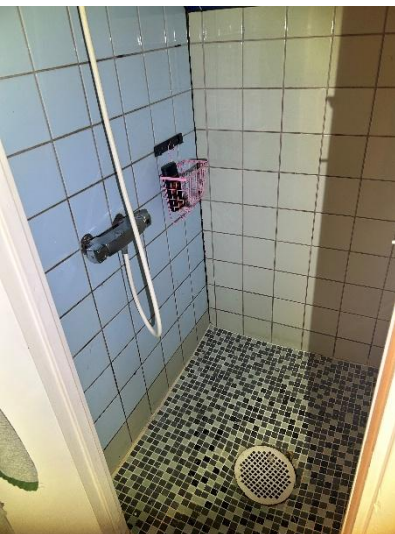
Äldre duschutrymme med gjutjärnsbrunn.
