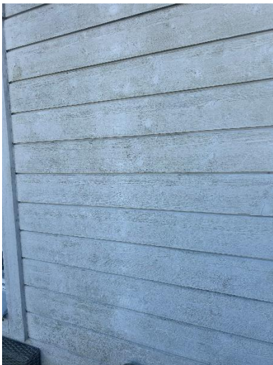
Underhåll/målningsbehov av träfasaden.
